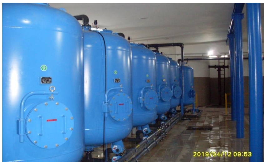
Fot. 1. Stacja Uzdatniania Wody w Malcie.
